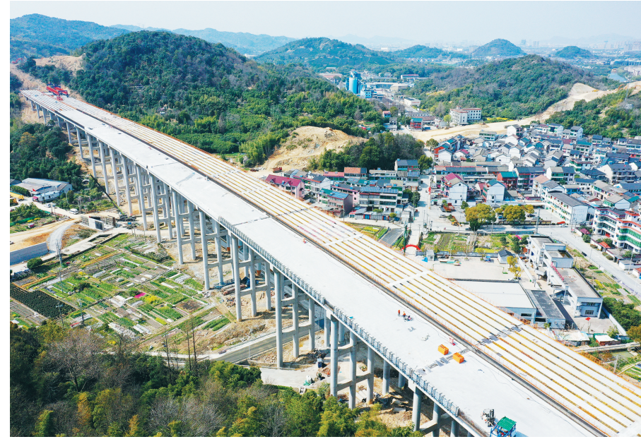
正在建设中的杭金衢高速公路柯桥联络线工程。 通讯员 沈潇 摄
